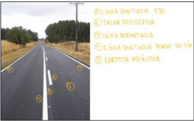
Figura 30. Sección transversal antes de intervención
