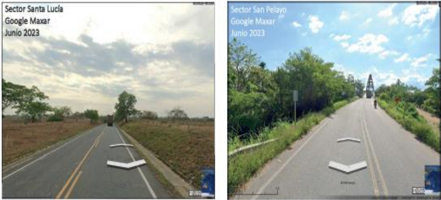
Figura 17: Izquierda: vía en el Sector de Santa Lucía, con pavimento en las bermas, donde se aprecia para 2023, el estado de conservación del corredor. Derecha: vía 25 km adelante de la anterior, en el sector de San Pelayo, en la misma época, con la vegetación apoderándose de las zonas laterales y franja de servicio. Fuente: Google Maxar.
