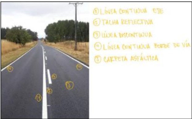
Figura 30. Sección transversal antes de intervención
